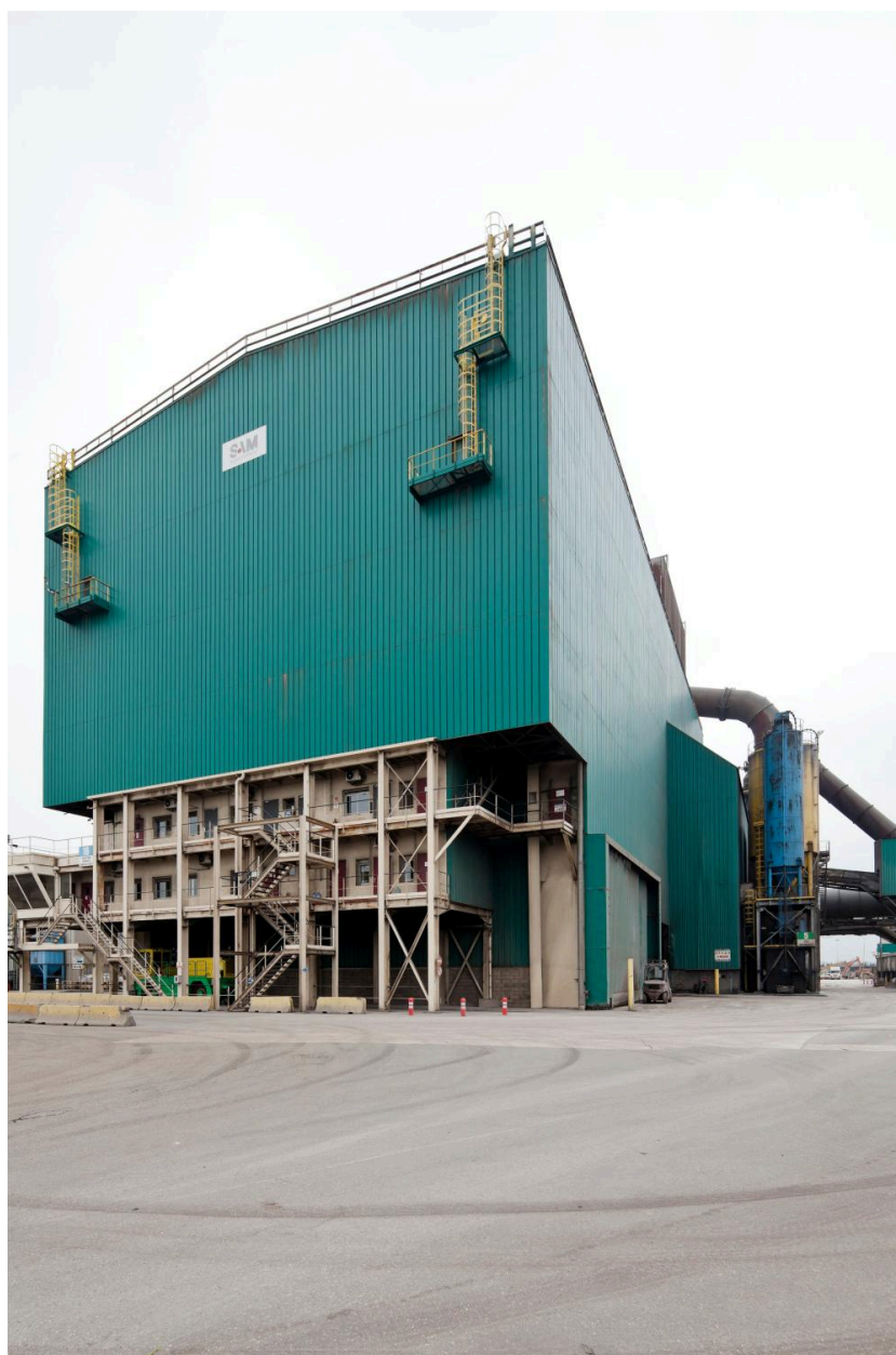
Vue de la halle du four. (réf. Département de Seine-et-Marne : IVD77_2013_77_00268_NUCA)
