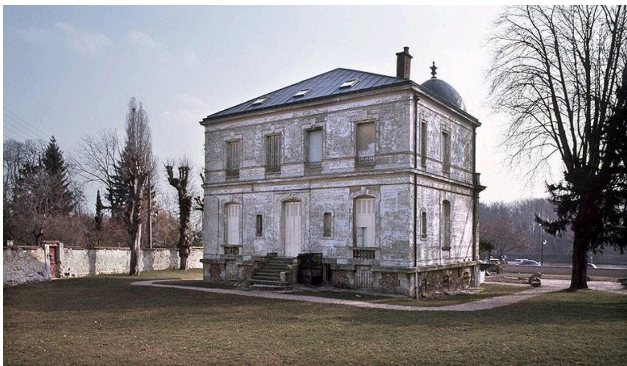
La façade postérieure.
