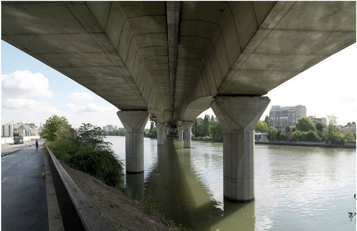
Choisy-le-Roi, Alfortville, Vitry-sur-Seine. Pont de Choisy de l'A86. Autre vue du dessous des tabliers.
