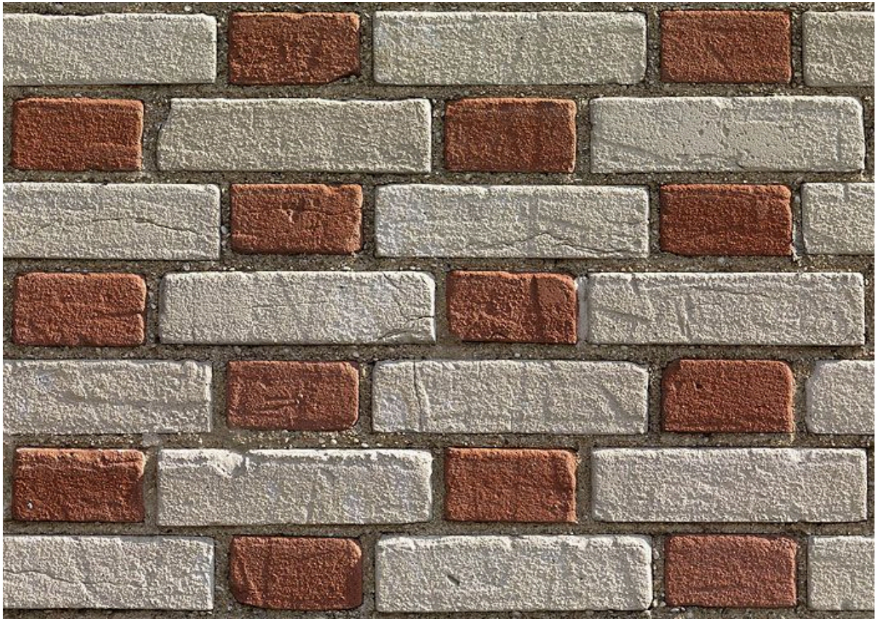
94, Ivry-sur-Seine, usine , boulevard de Brandebourgl . Détail de l'appareil de brique polychrome de la façade sur la rue.
