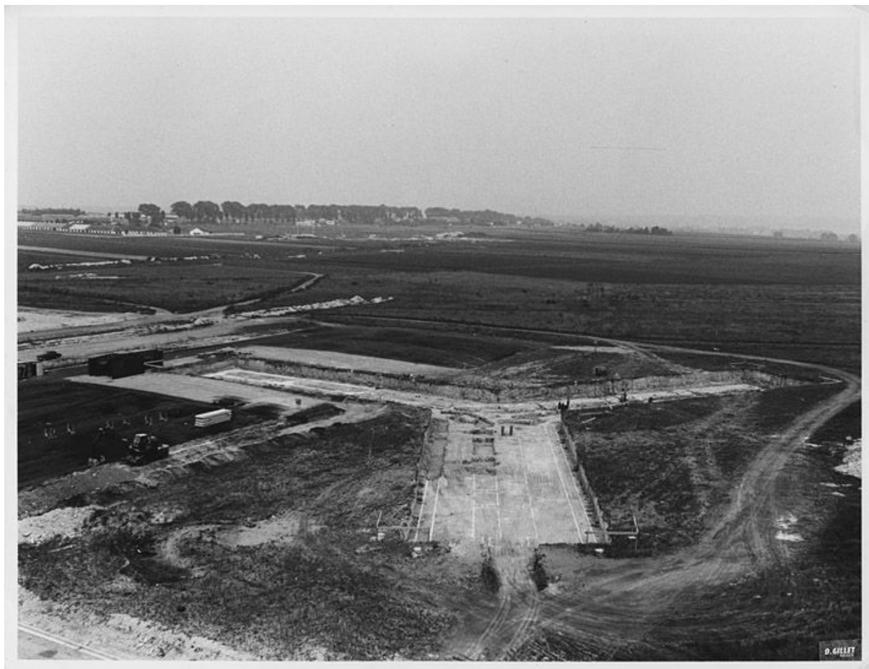
Début du chantier de construction d'une des tours de Meaux-Beauval. (OPAC Meaux)
