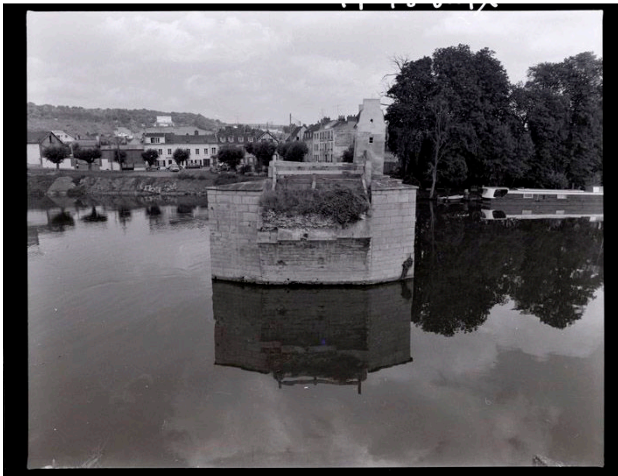
Pont routier dit Vieux pont de Limay. Vue depuis la rive gauche.
