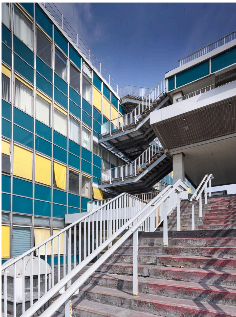
2018, terrasses, circulation verticale: escalier ouest, 4ème étage.
