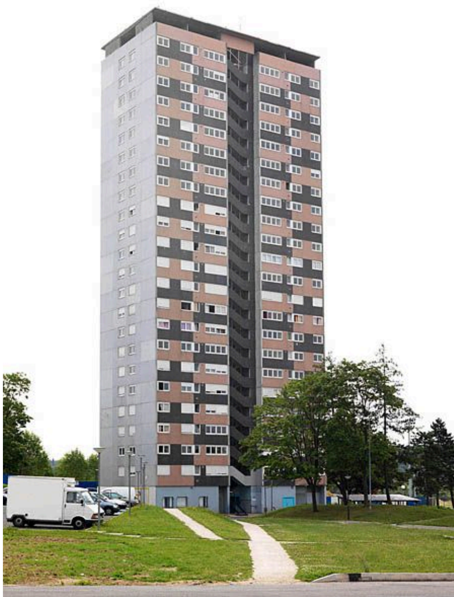
Une tour de la Pierre-Collinet. Façade avant avec escalier.
