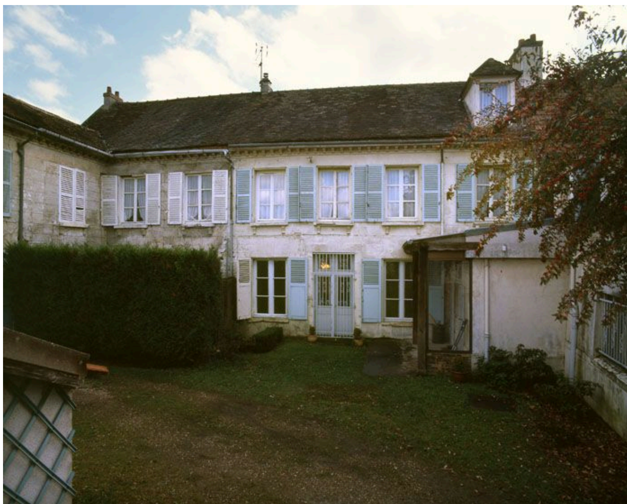
Vue d'ensemble de la façade antérieure.
