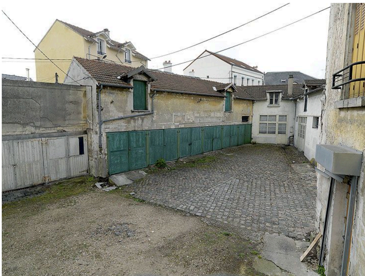
Maison 1 rue François-de-Tessan : la cour, vue de l'angle nord-ouest.
