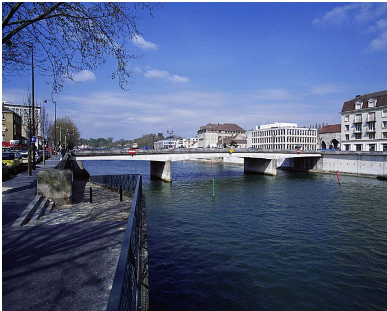
Vue générale, depuis l'amont.
