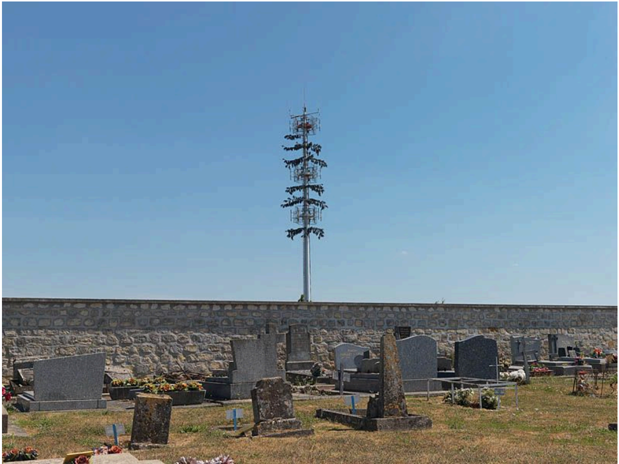
95, Bonneuil-en-France, rue du Pont Yblon. Vue du cimetière avec antenne relais.
