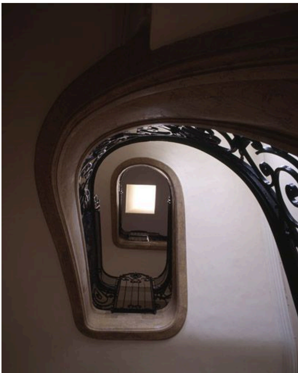
L'escalier : vue en contre-plongée.
