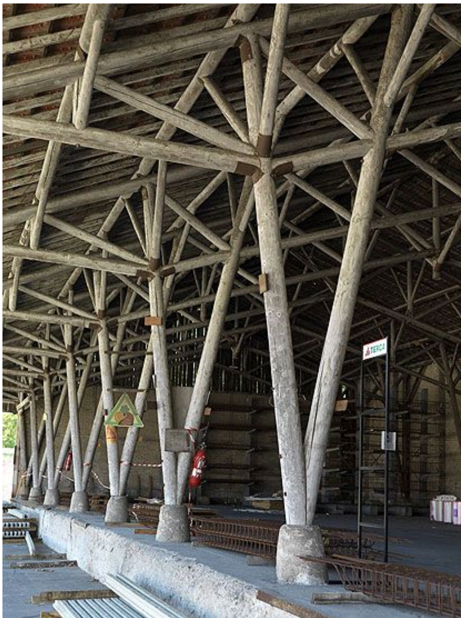
Choisy-le-Roi, entrepôt industriel de l'ancienne faïencerie Boulenger XX, 138 avenue de Villeneuve-Saint-Georges. Halle à la charpente en rondin dite canadienne.
