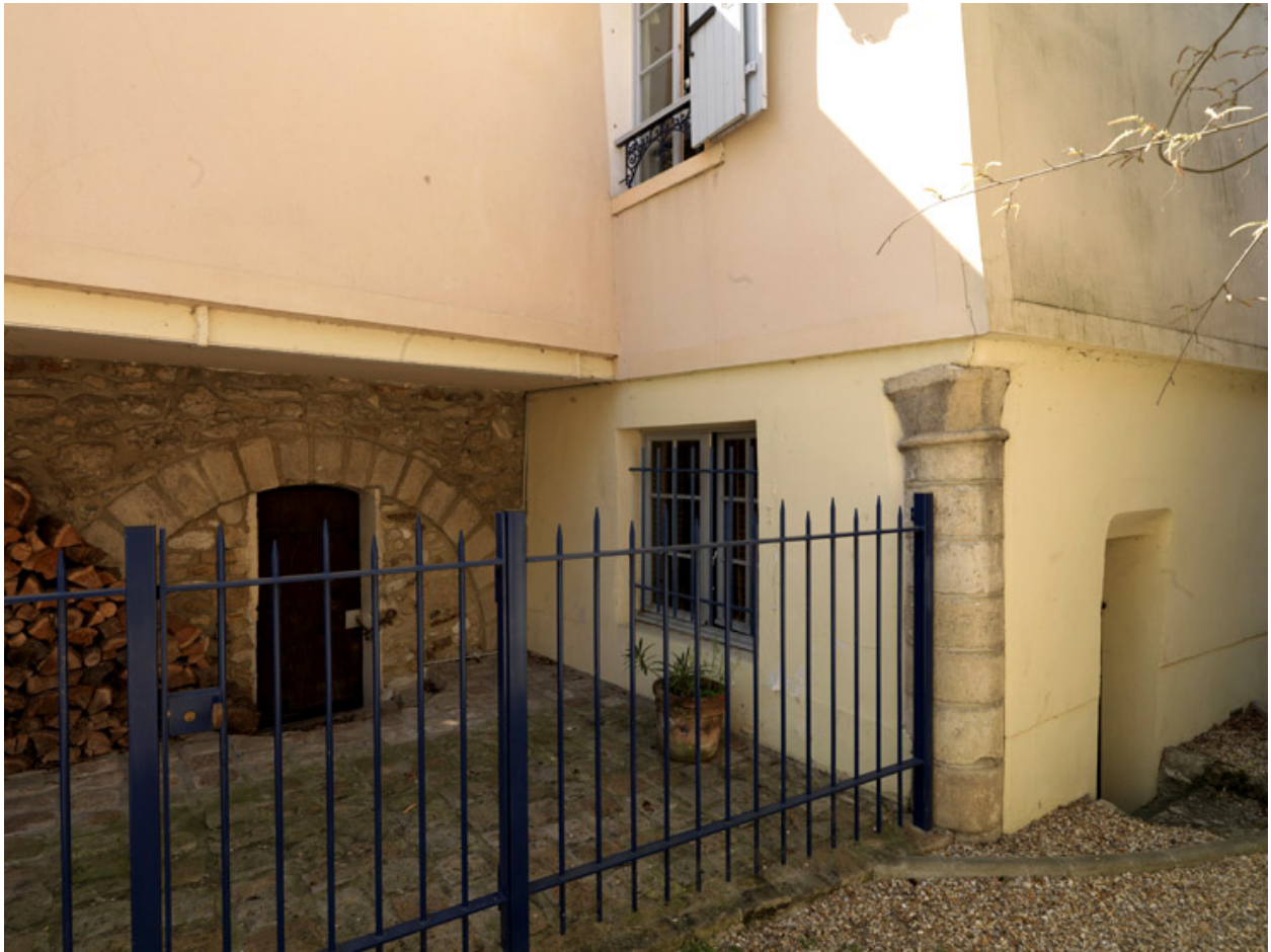
Vestige d'entrée d'atelier, rue Basse des Tanneries.
