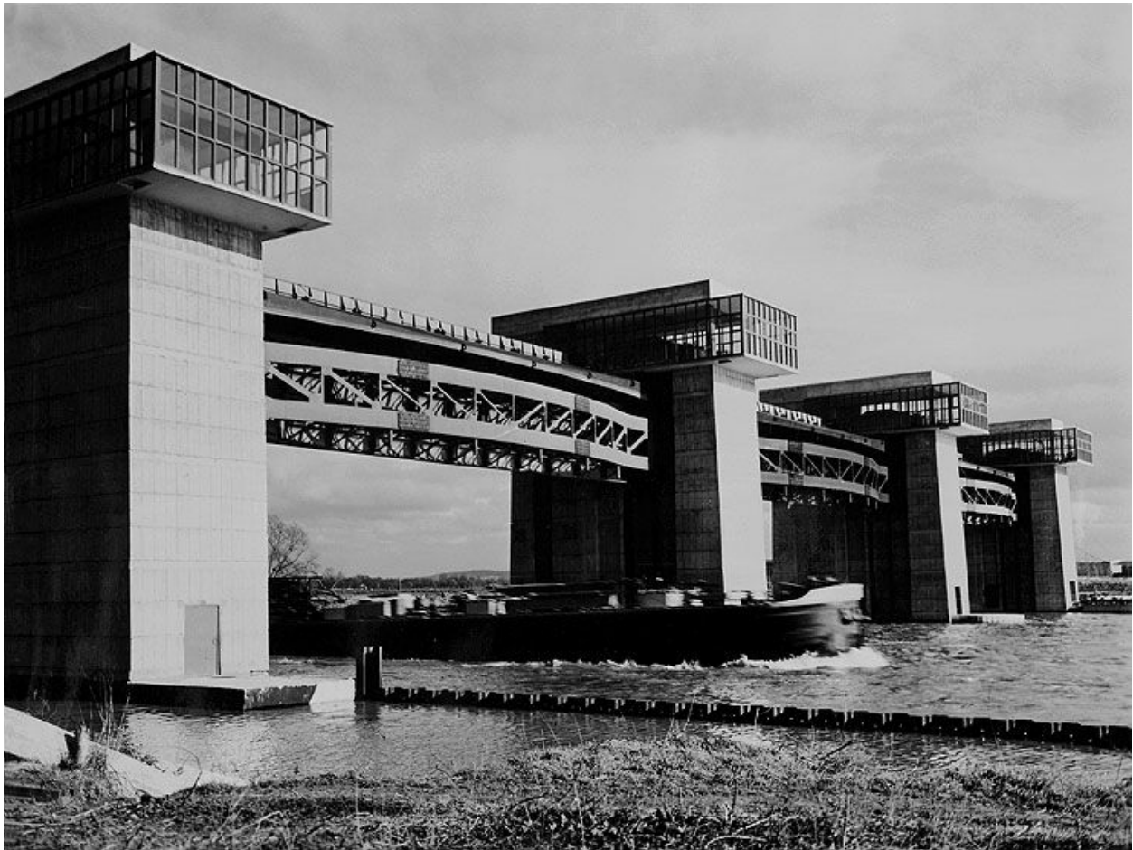
Vue d'aval pendant une crue de la Seine, vannes ouvertes. Photographie. (Musée de l'Ile-de-France).
