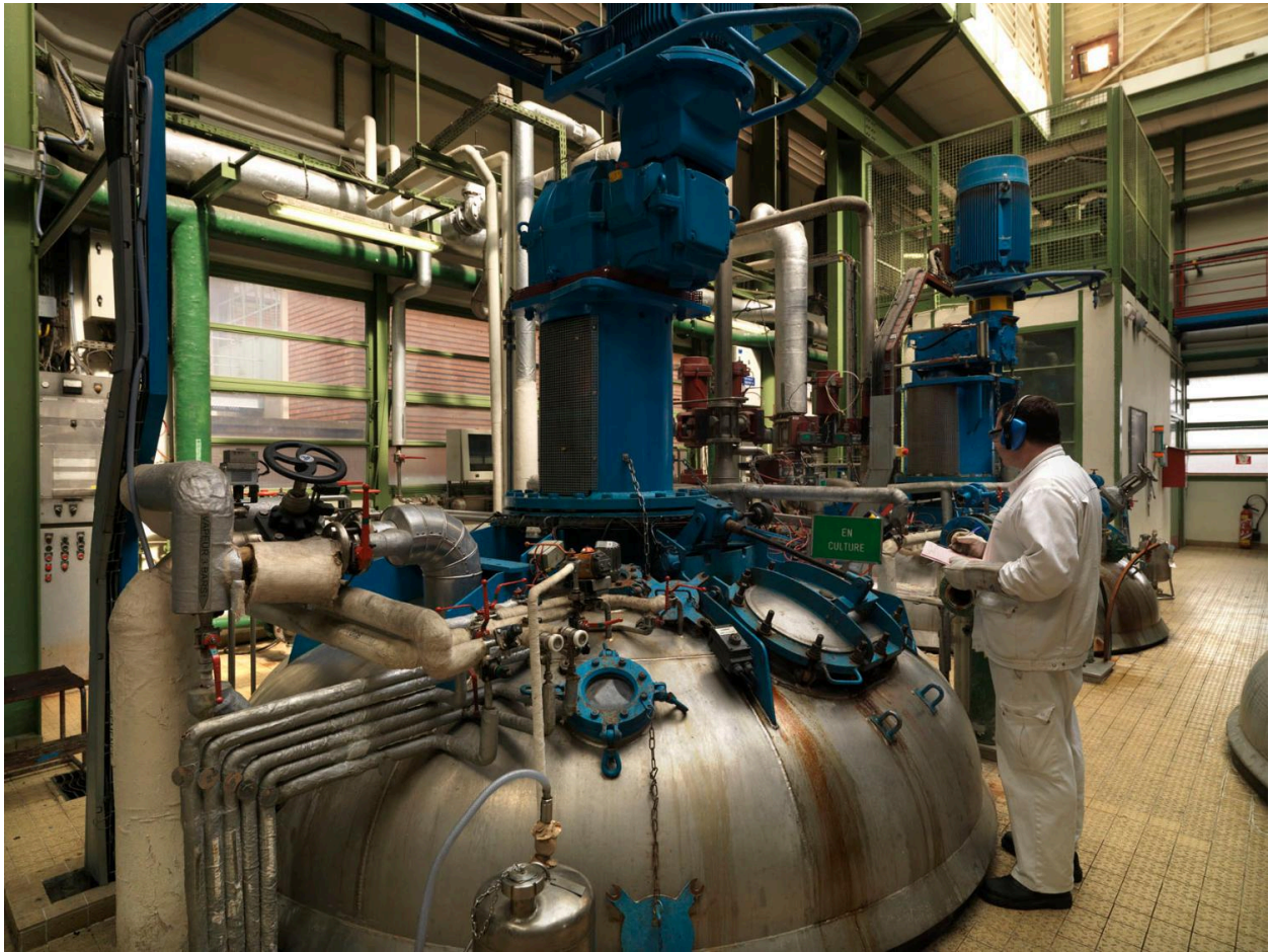
Site Sanofi. Bâtiment de transformation. Agent effectuant le contrôle d'une cuve.
