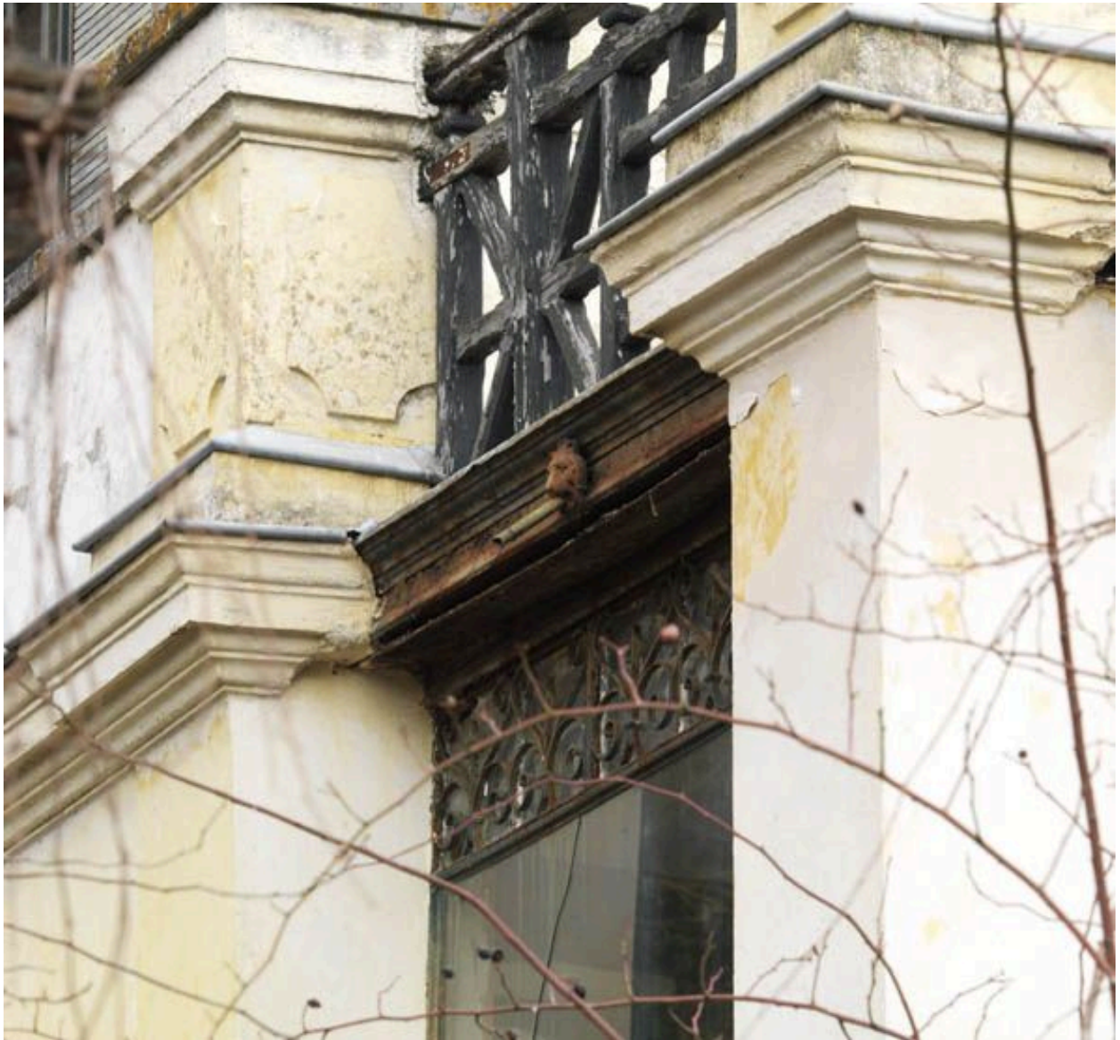
Villa des Fontaines-Dieu, travaux de serrurerie et construction métallique exécutés par l'entreprise Oudiou de 1896 à 1910.
