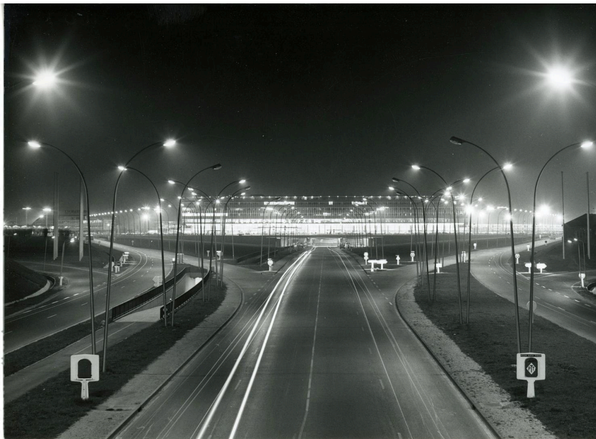
1961 1966, Les Installations terminales vues depuis le nord.
