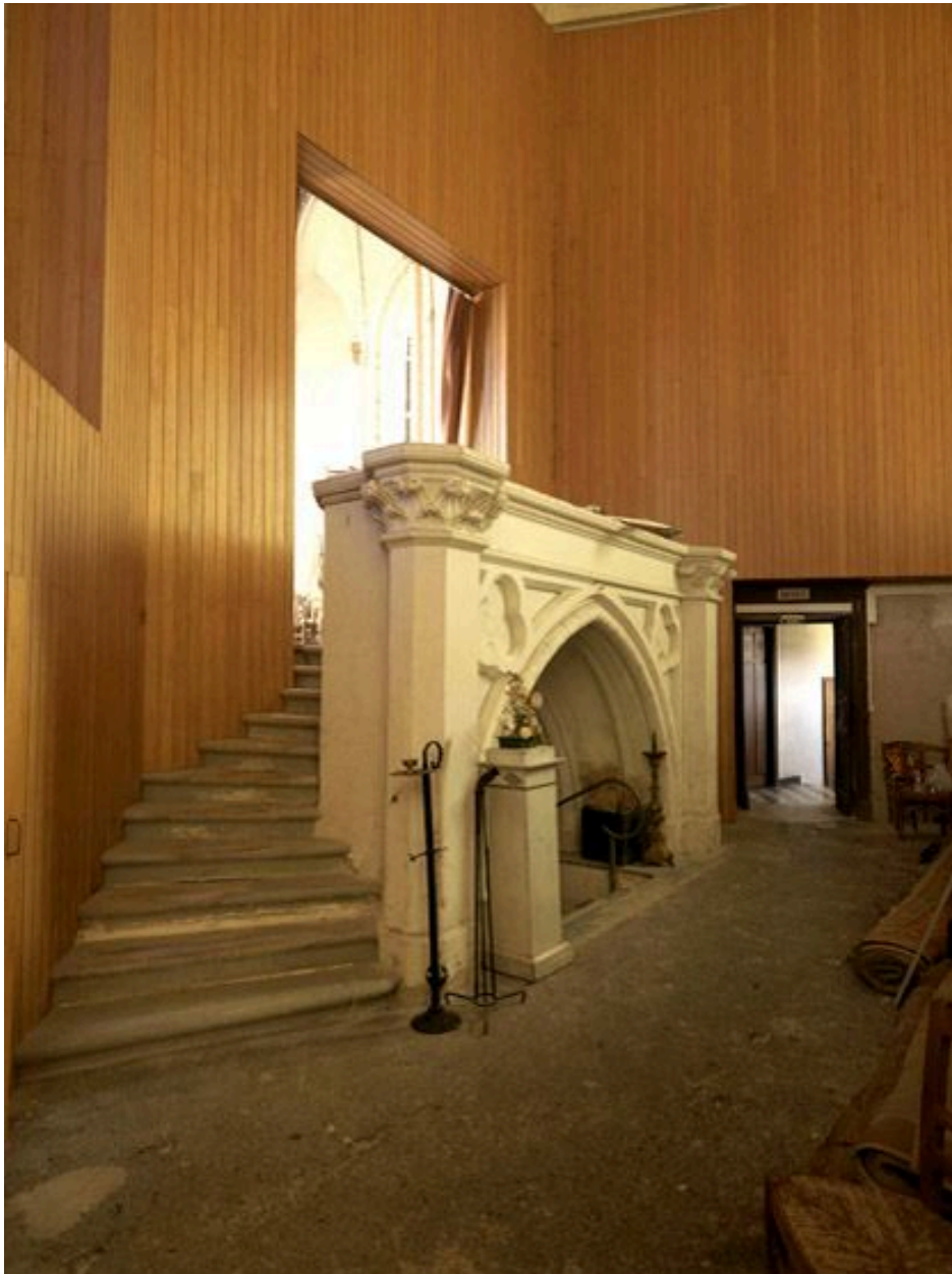
La partie orientale de l'église : vue intérieure, depuis le nord. L'escalier mène à la chapelle axiale (escalier latéral, tournant) et à la crypte (escalier central, droit).
