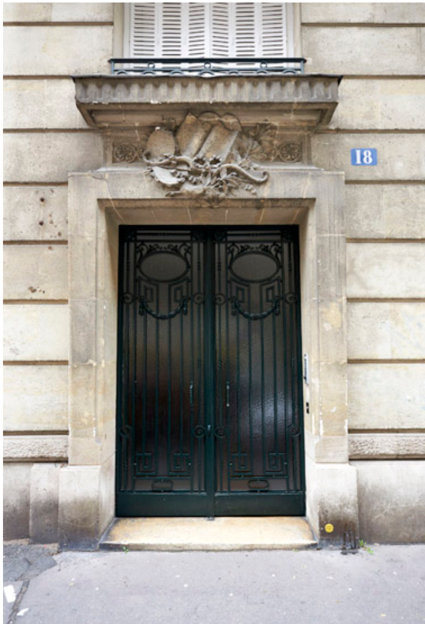
Vue du motif sculpté de la porte du 18 rue Ernest Cresson, immeuble mitoyen du n°20.
