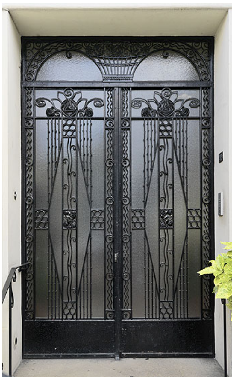
Vue de la porte d'entrée : ouvrage de ferronnerie d'art de style Art Déco.
