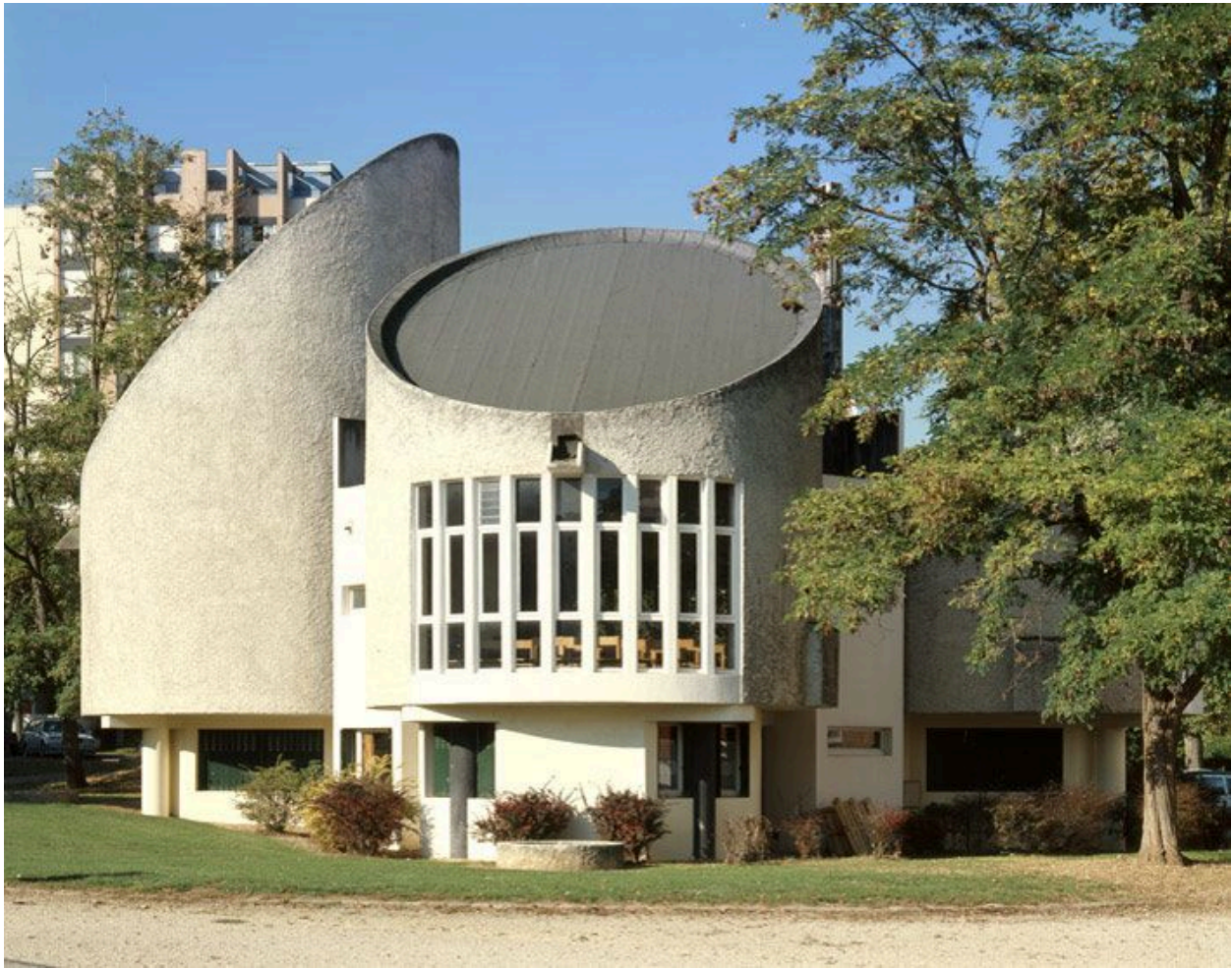
Vue extérieure, depuis l'est.
