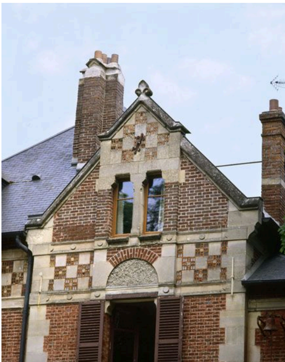
Détail du décor de la façade antérieure.
