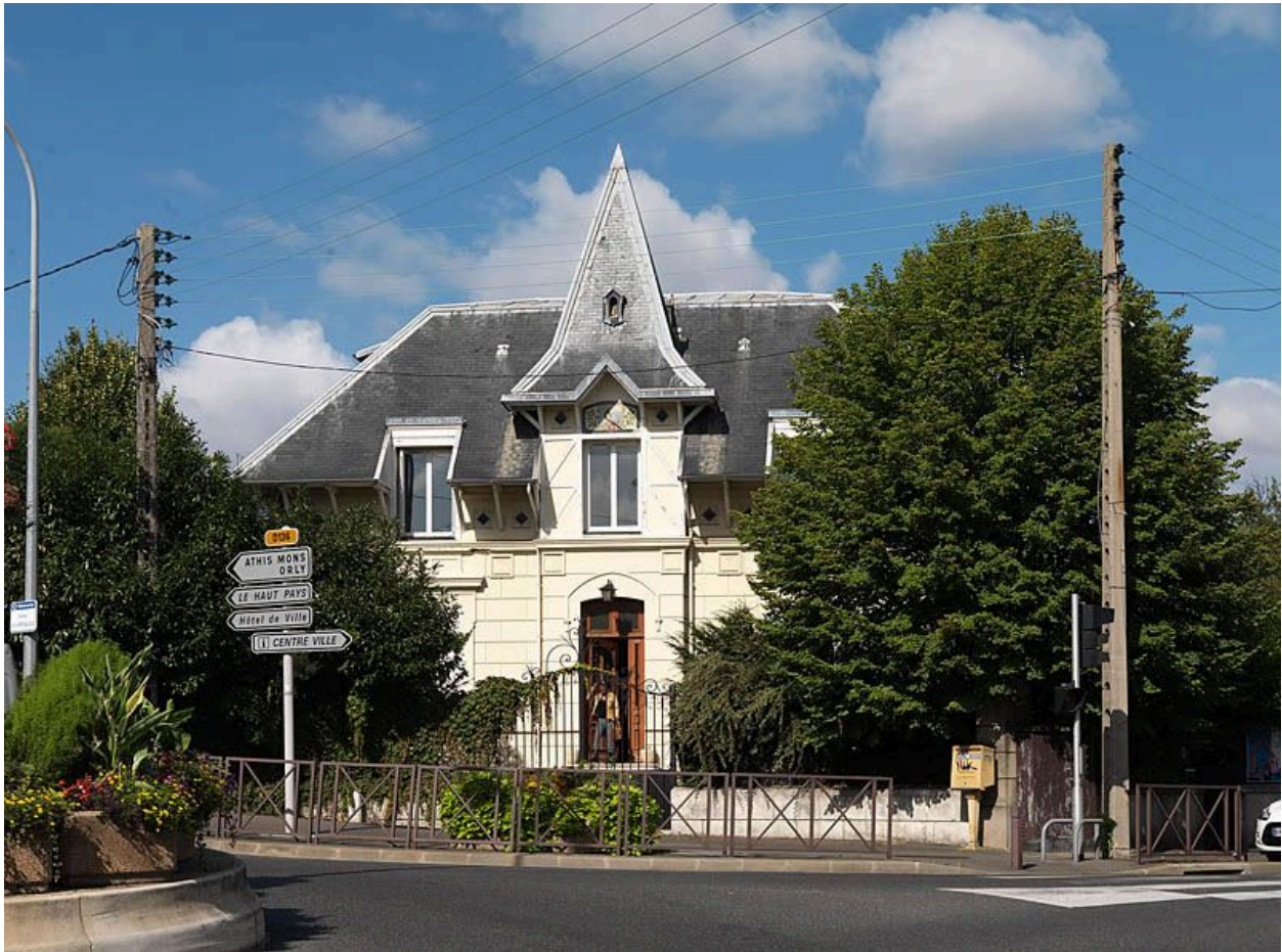
Villeneuve-le-Roi, maison, 1 rue du Maréchal Joffre, place de la République. Vue d'ensemble en 2011.
