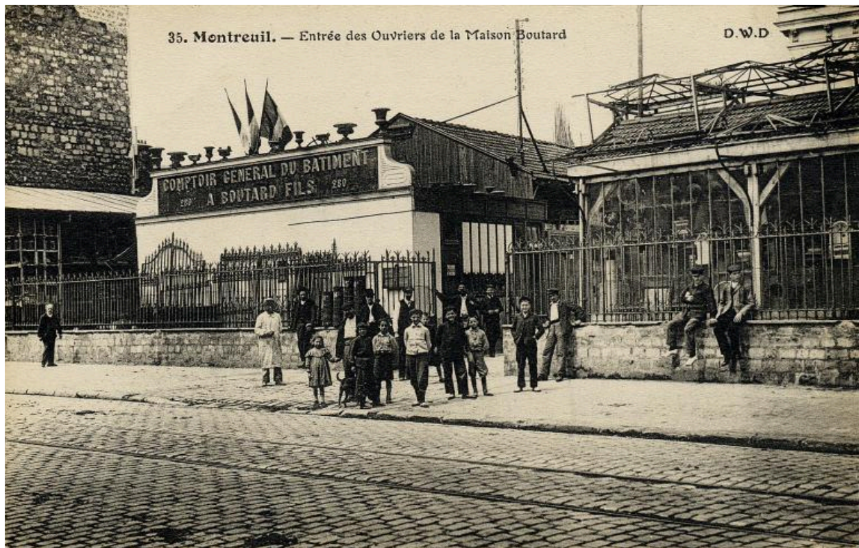
Entrée des ouvriers du comptoir général du bâtiment Boutard fils, 280, rue de Paris, vers 1910. Carte postale. (Musée de l'histoire vivante, Montreuil. 7 F 27)
