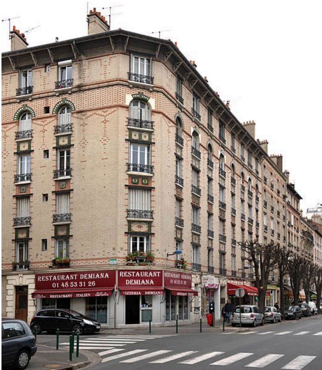
Choisy-le-Roi, immeuble, 26 avenue Anatole France, 2 rue Alphonse Brault. Vue d'ensemble.
