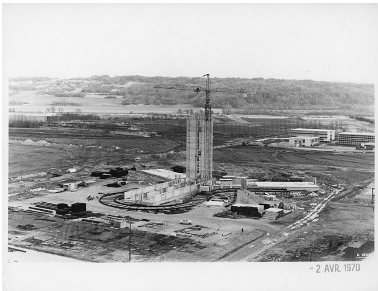
Construction de la caravelle Cornouaille avec le Lycée Beaumarchais (à valider) en arrière plan. 2 avril 1970. (OPAC Meaux)
