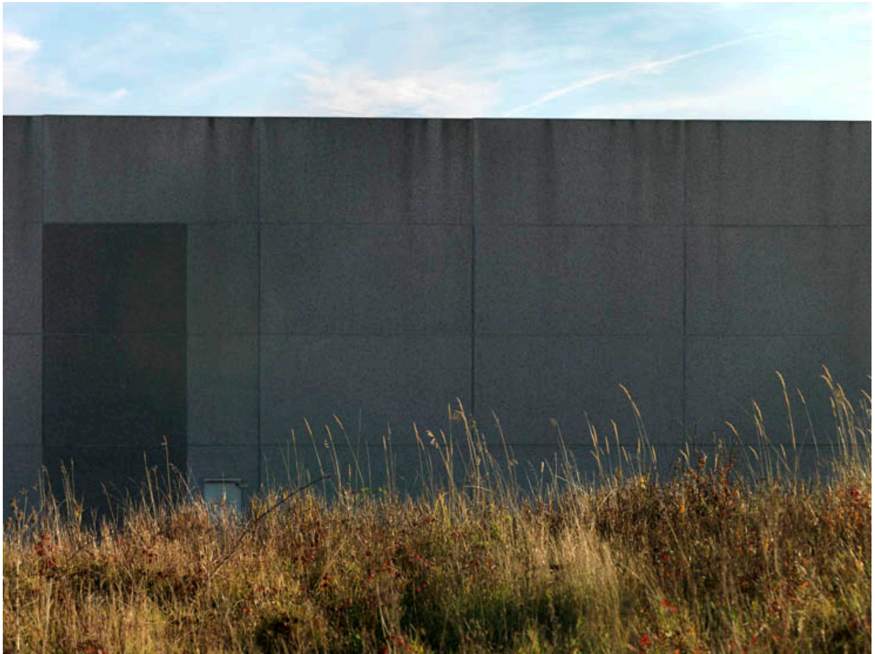
Survilliers. ZI de la Porte des Champs. Entrepôt logistique. Bardage.
