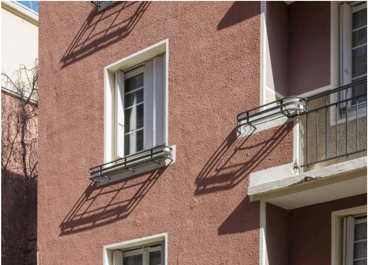
Façade du bâtiment latéral (3)
