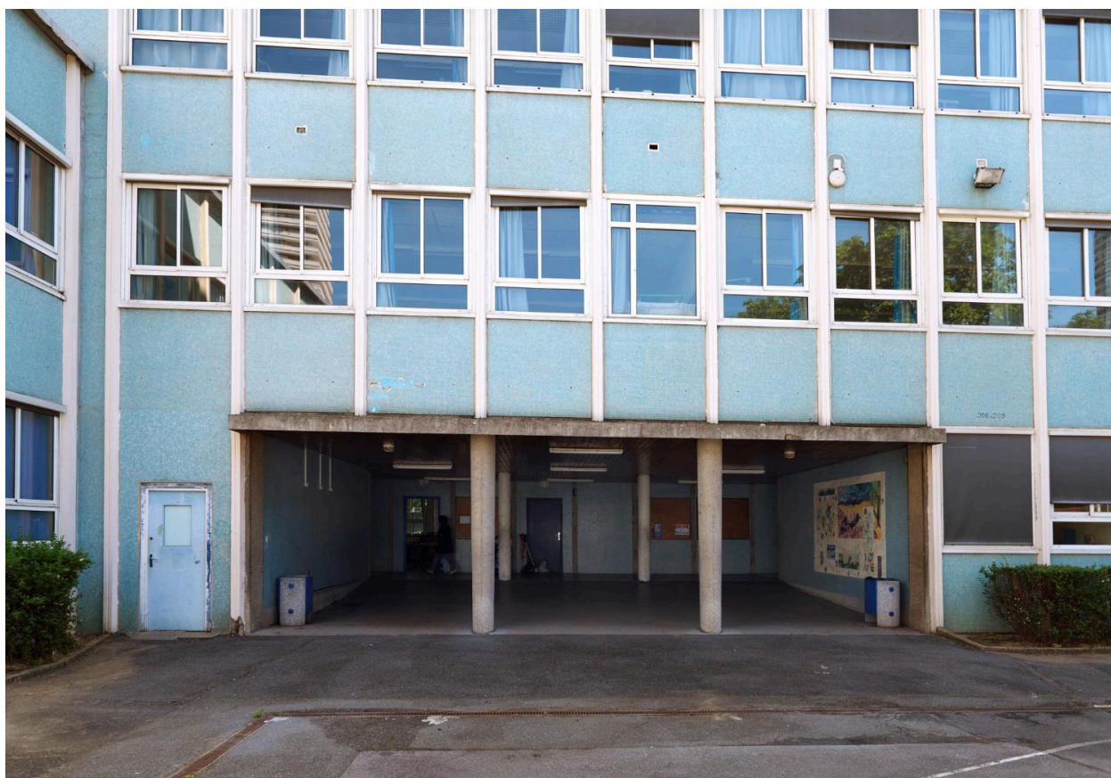
La trame du bâtiment de l'externat et l'un des préaux qui en percent le rez-de-chaussée.
