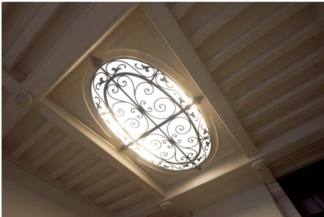
Vue du plafond du bâtiment construit sur cour.
