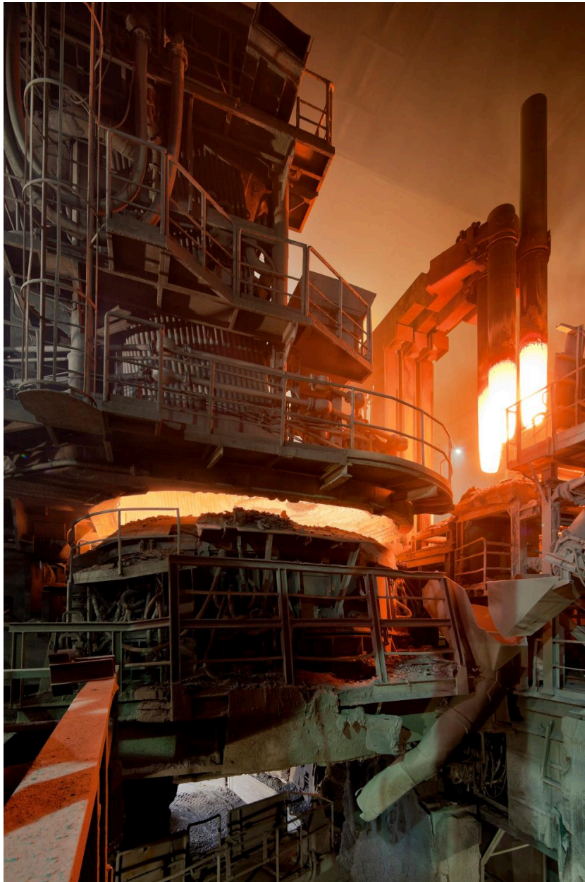
Halle du four, four électrique avec les trois électrodes en graphite permettant d'obtenir la fusion. (réf. Département Seine-et-Marne : IVD77_2013_77_00242_NUCA)
