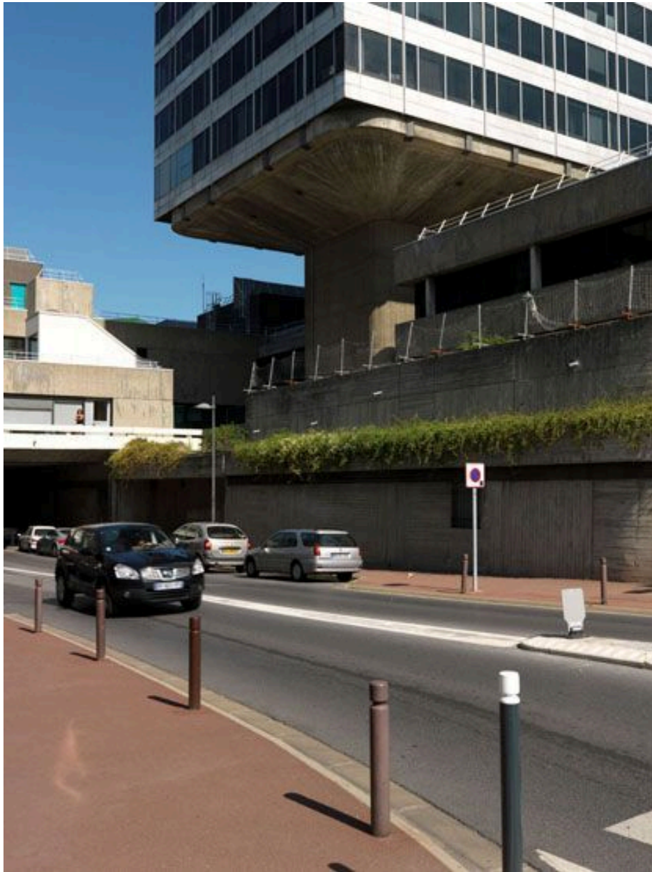
Vue de la rue de la préfecture qui pénètre sous la dalle.
