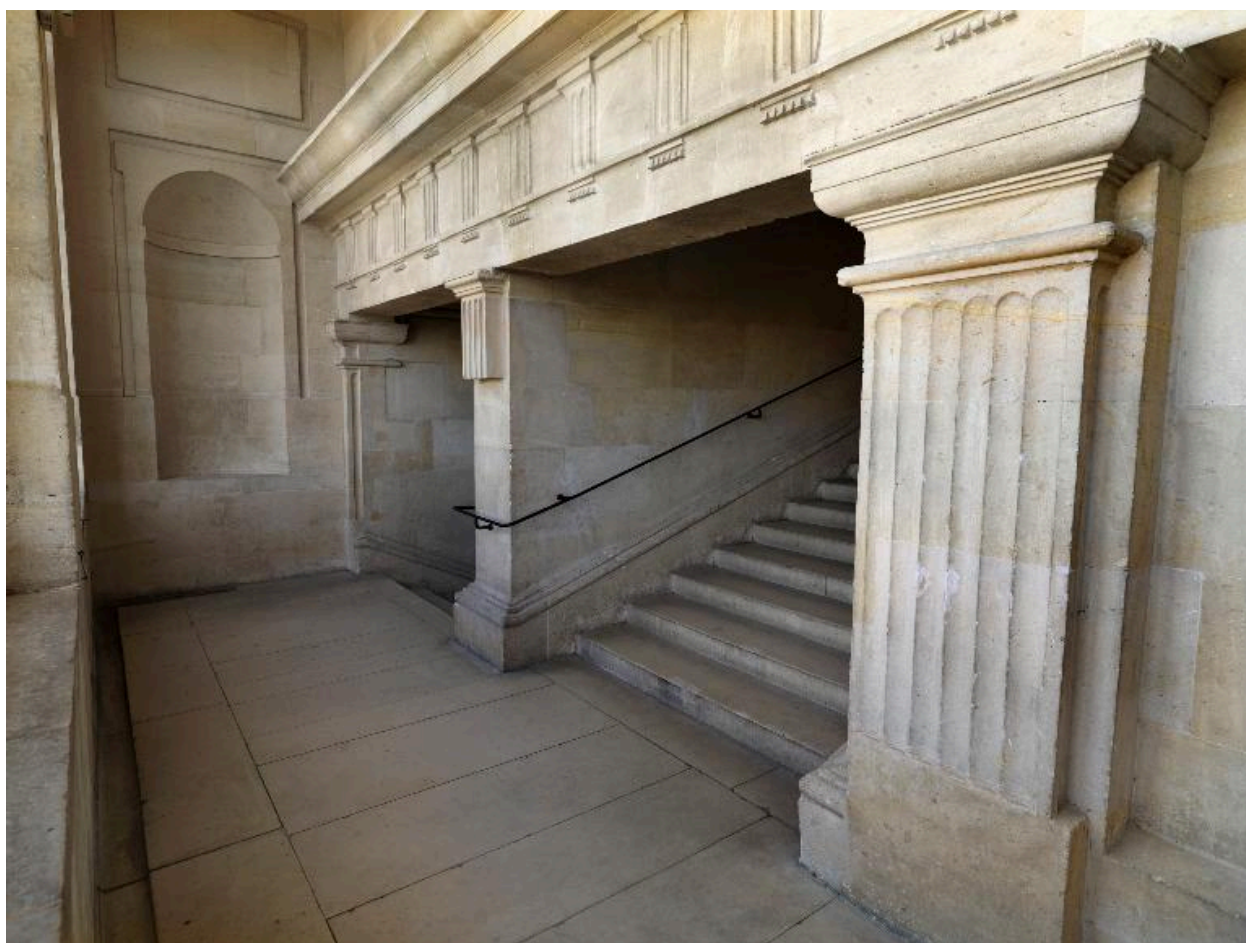
Repos de l'escalier aménagé par Jean Bullant pour desservir les appartements royaux, dans l'aile nord. Vue prise depuis l'ouest.
