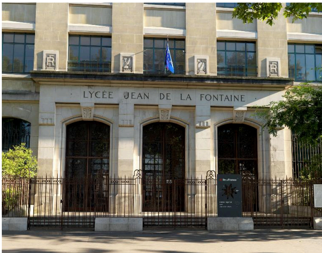
Détail de l'entrée.
