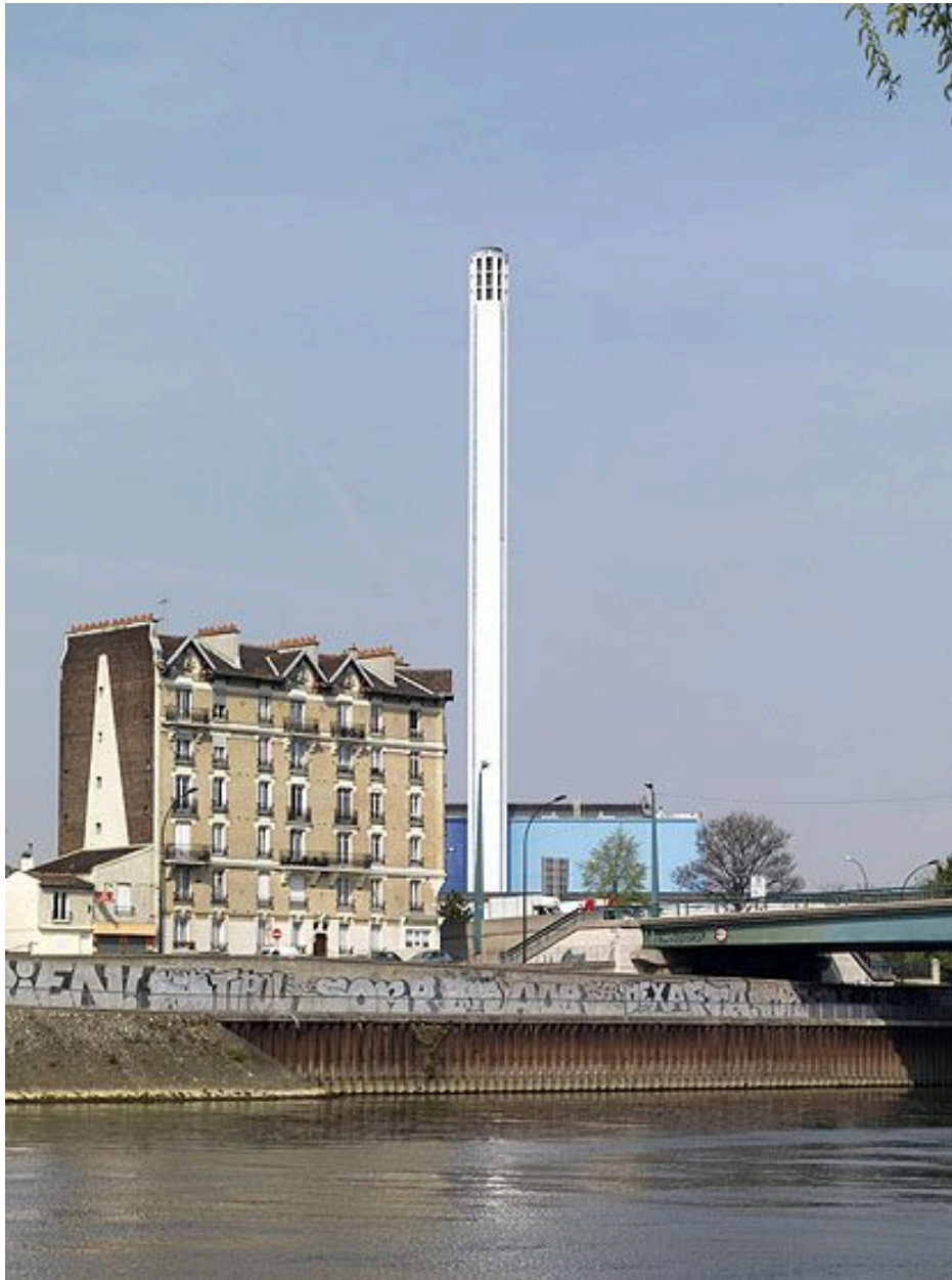
Ivry-sur-Seine, immeuble à logements, 2 quai Henri-Pourchasse. Vue de l'immeuble et d'une partie du pont d'Ivry.
