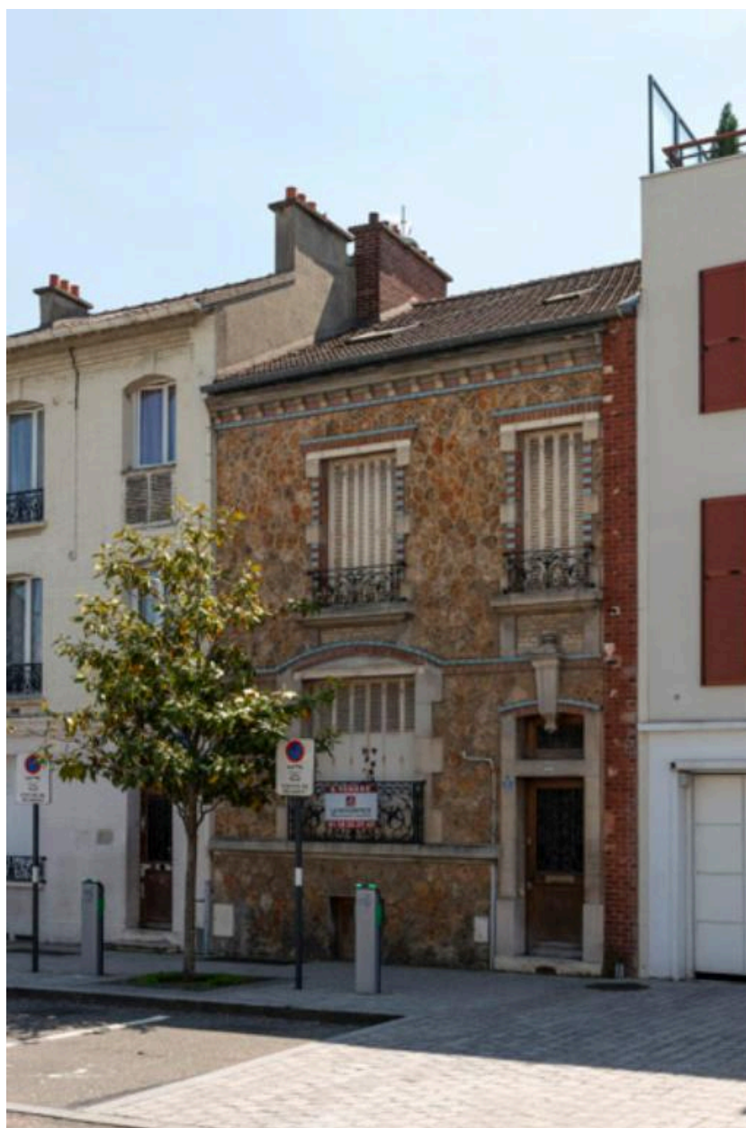
Les Mureaux. Maison de bourg, 7, place de la Libération. Vue d'ensemble de la façade.
