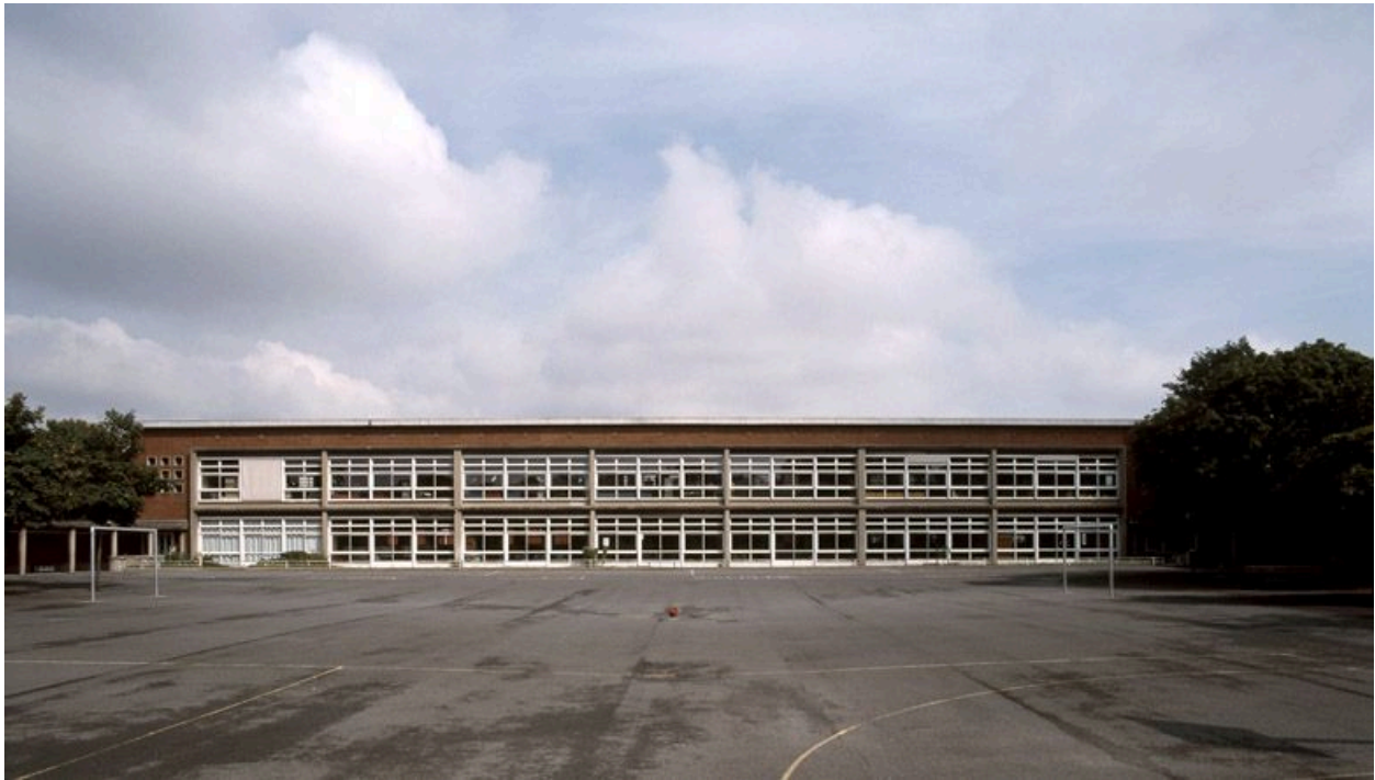
Groupe scolaire Joliot-Curie, rue Irène Joliot-Curie. Julien Heulot (architecte communal). Vue d'ensemble du bâtiment de classe, ouvert en 1956.
