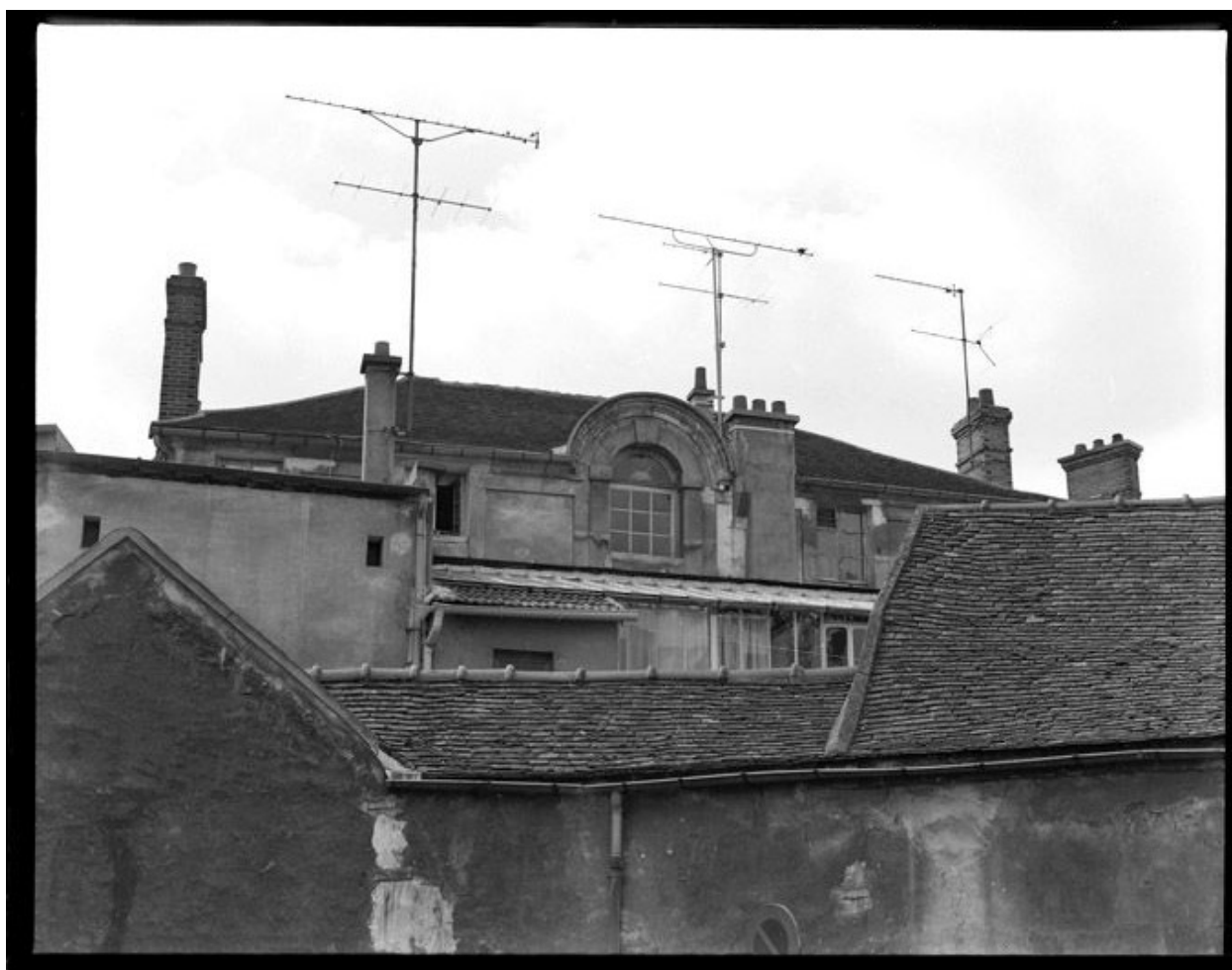
Maison, Gambetta (rue) 4. Vue d'ensemble de la toiture sur la façade postérieure.
