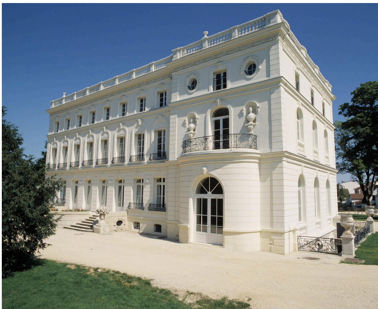
Vue de la façade antérieure.
