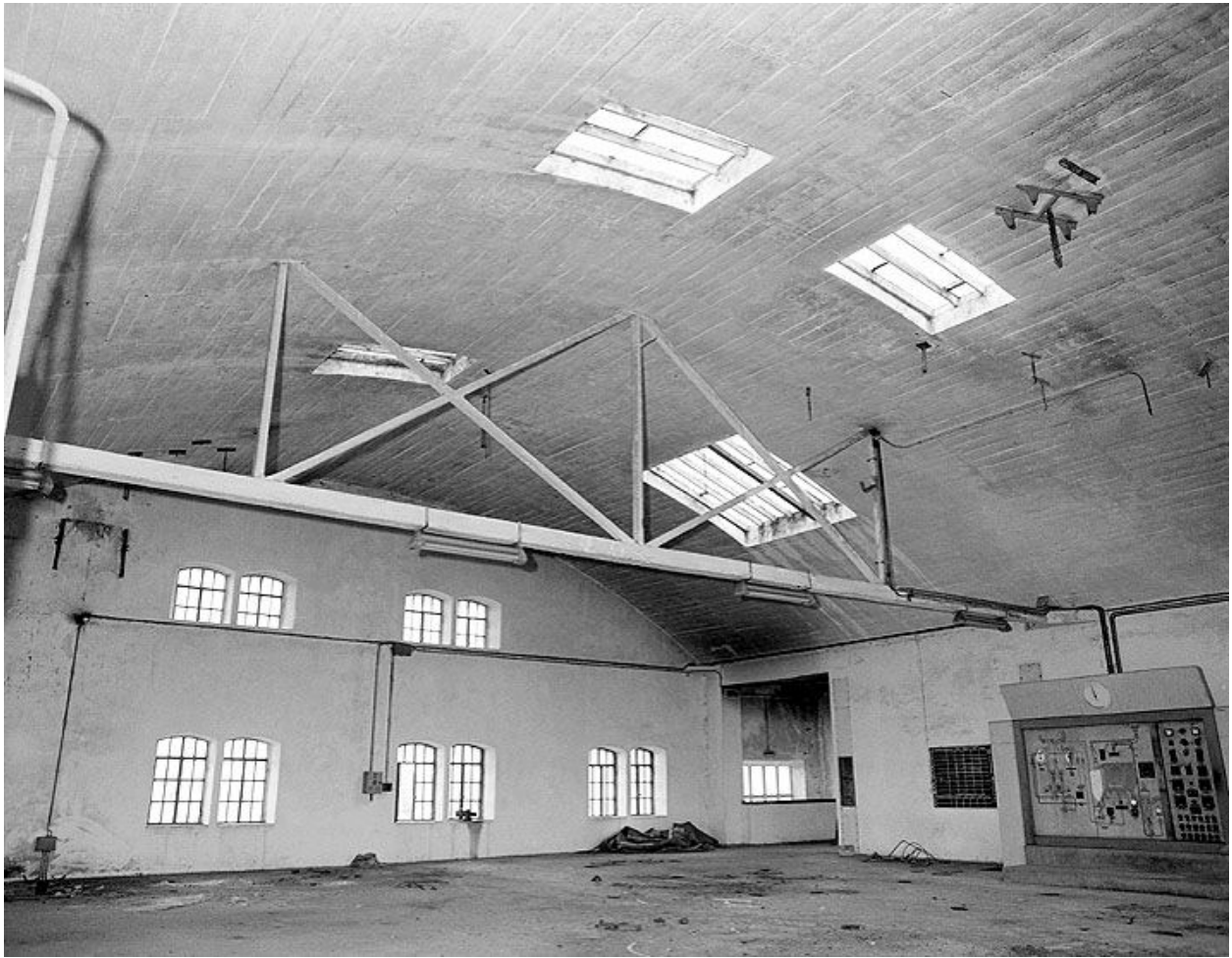
Comble des silos. Photographie avant destruction, 1989. (Ministère de la culture, Inventaire général. 89SG718X)
