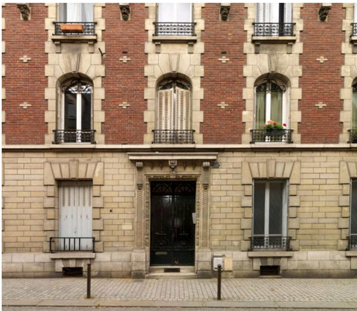
Immeuble aligné , 20, rue de Chanzy. Le soubassement en pierre contraste avec l'élévation en brique.
