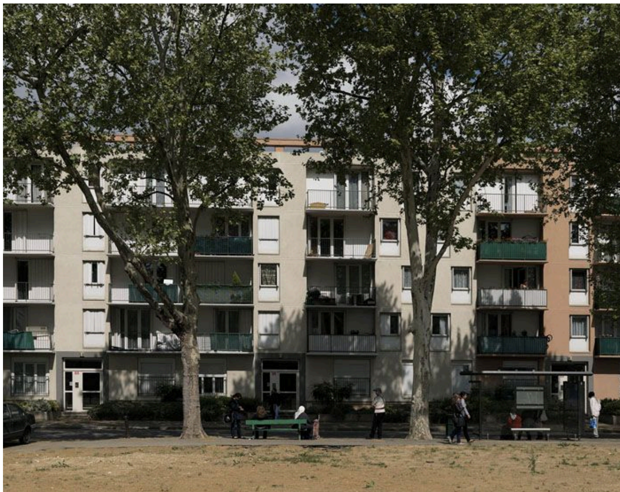
Façade principale de la barre B.
