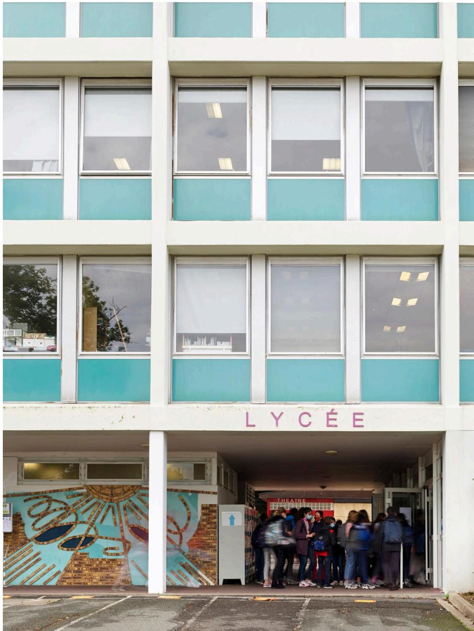
Détail d'une façade. Le remplissage est constitué de panneaux industrialisés légers, à cadre métallique en aluminium.
