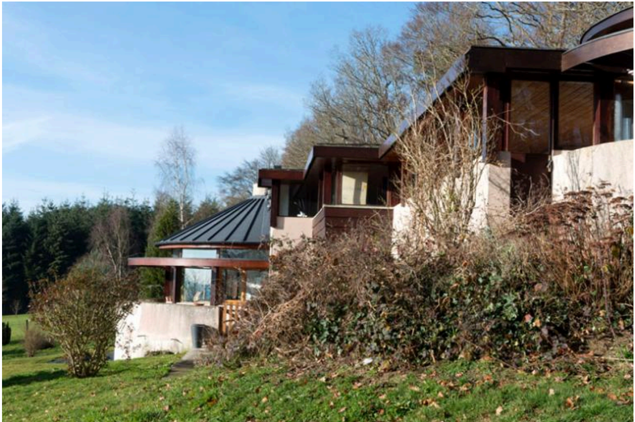
Vue latérale rapprochée de la maison.
