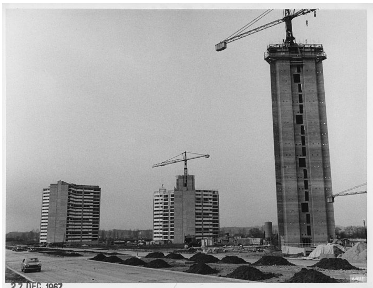
Chantier de construction des premières tours en 1967. (OPAC Meaux)
