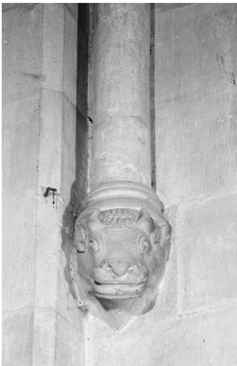
Culot : tête de taureau (pilier sud-est de la croisée, face nord).
