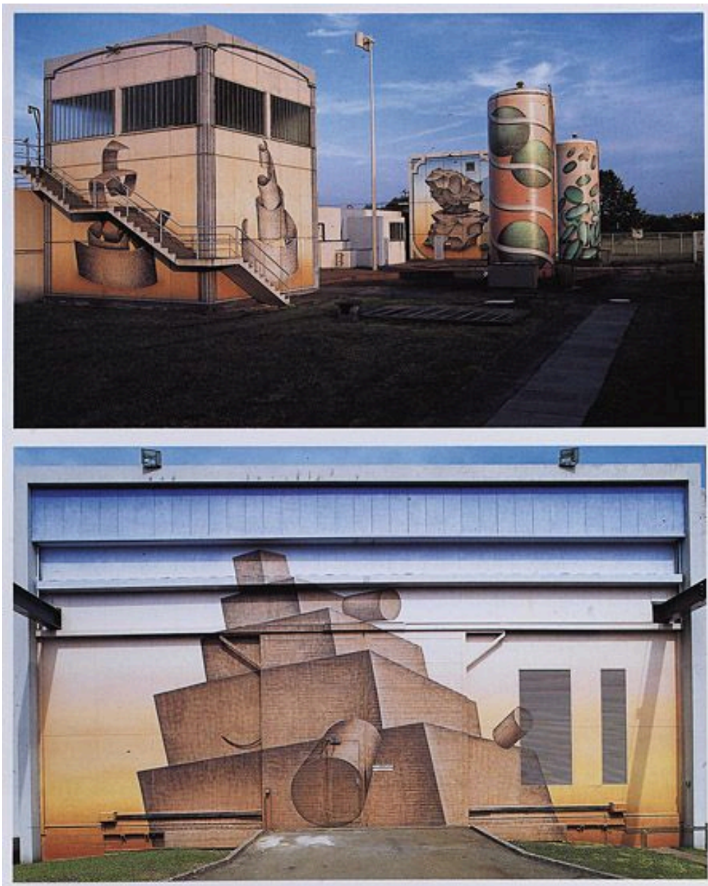
Orly, établissement des eaux dit usine de traitement des eaux d'Orly. Installations ornées de fresques de Gérard Pestmal. Tiré de : Orly. usine de traitement des eaux. In L'eau de Paris / M. Gaillard, C. Abron. Edit. Martelle, 1995. p. 154-160.
