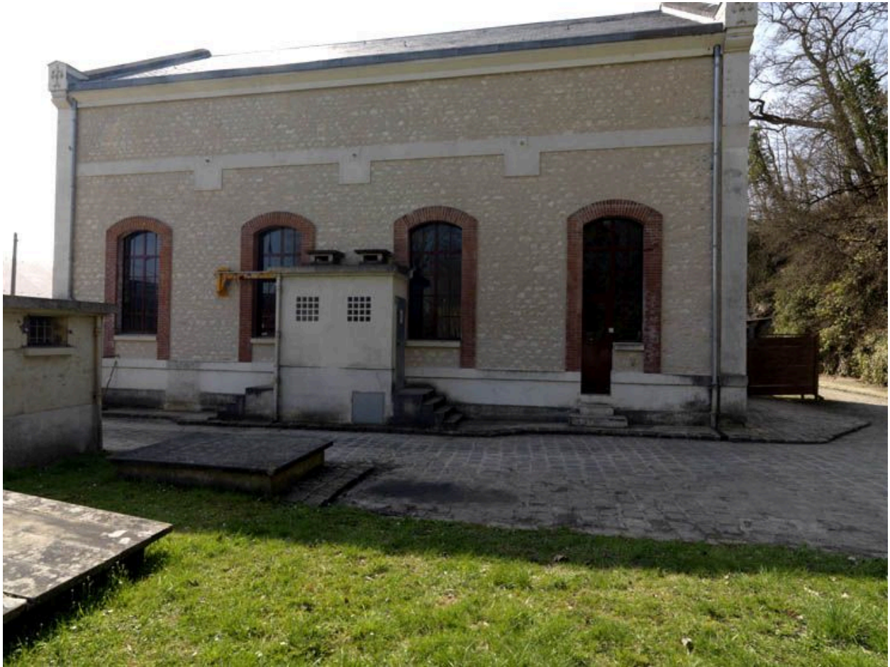
Bâtiment des pompes, façade nord.
